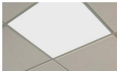
Pose de pavés LED à encastrer dimmables, afin que l'éclairage artificiel s'adapte automatiquement à l'apport de lumière naturelle.
