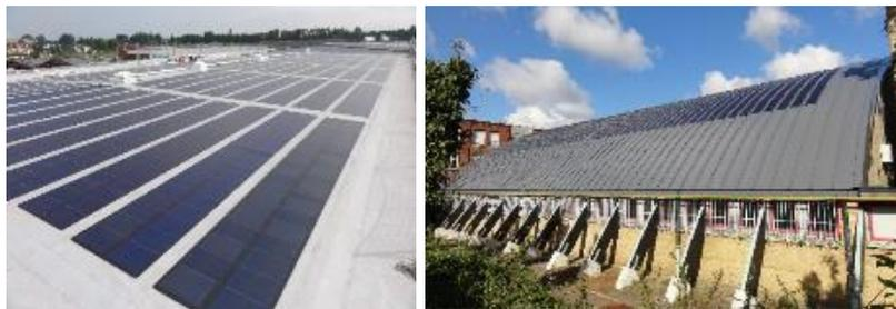
Centrales photovoltaïques utilisant des cellules amorphes (source : Cohérence Energies)
