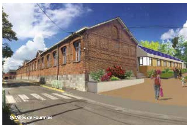
Projet de toitures photovoltaïques sur l'école Aragon de Fourmies.
