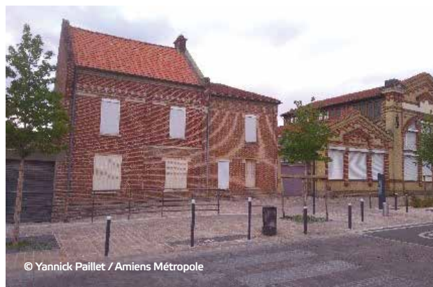
Le futur démonstrateur de la rénovation énergétique des maisons amiénoises : maison de ville 1900, utilisation de matériaux biosourcés, performance énergétique de 104 kWh/m 2 /an (BBC rénovation) et mesure de performance réelle
