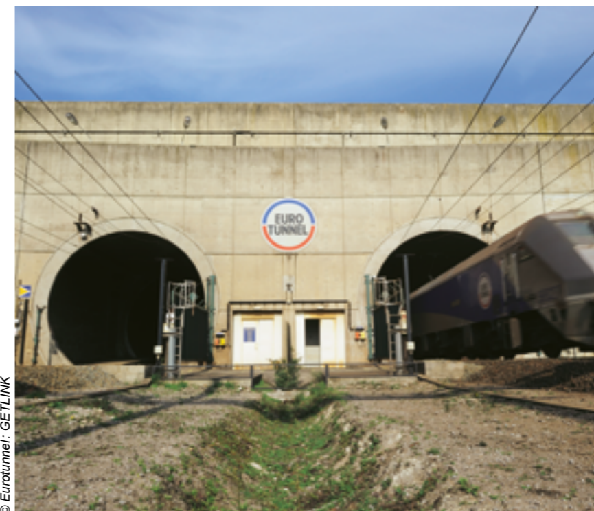
Tunnel sous la Manche.
