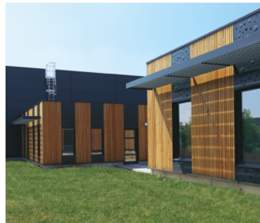
Batiment clé en main l'AMORCE situé sur le Parc des Autoroutes à Saint-Quentin (02).
