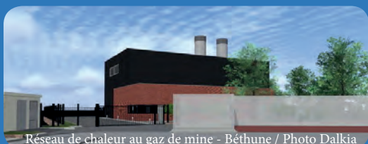
Réseau de chaleur au gaz de mine - Béthune / Photo Dalkia
